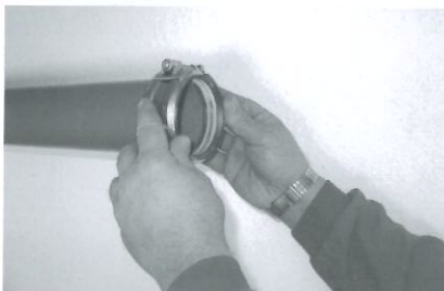
1. Rapid-Verbinder (1) DN 75/80 auf SML-Rohr bzw. Formstück DN 75/80 aufstecken
