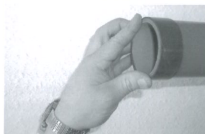
2. Schlauchstück 74/79 (2) auf SML-Rohr oder Formstück DN 70 aufstecken
