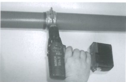
4. Rapid-Verbinder (1) anziehen (10-20 Nm)
